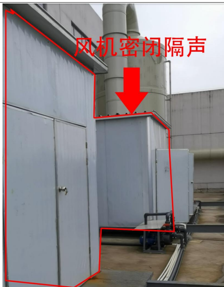
图 3-2、楼顶新增废气风机单独密闭隔声
