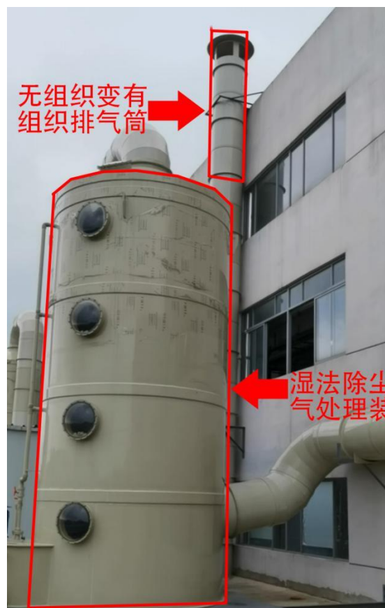
振动及进出口逸出粉无组织废气收集废气处理装置及排气筒（G8-1、G8-2）
